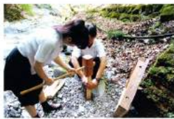
現地に杭を打ちました。地面が硬いためなかなか杭が刺さらず、大変でした。
