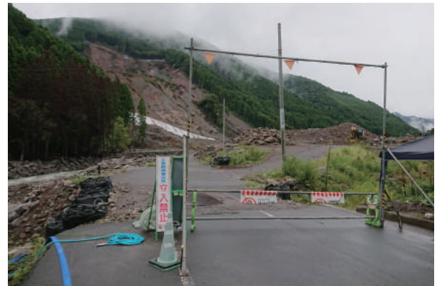
2017年7月九州北部豪雨の大規模土砂災害現場
