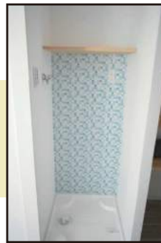
③ DK から洗濯パン 独立した、 洗濯パン すべてから露出していた洗濯パンを造作棚と組み合わせることで独立させ、空間からの露出をなくした。
