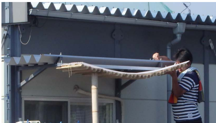
写真4 取り付け作業の様子
