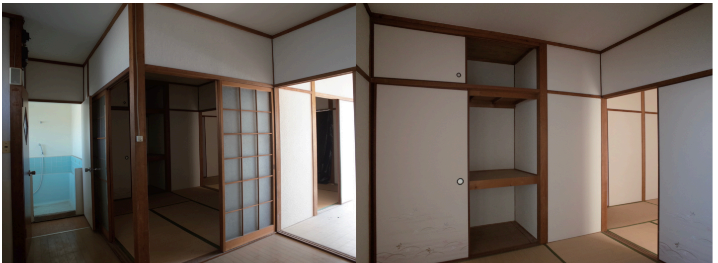
【202号室】リノベーション前
