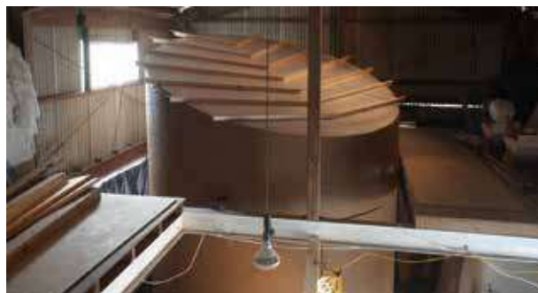
福間倉庫リノベーションプロジェクト
