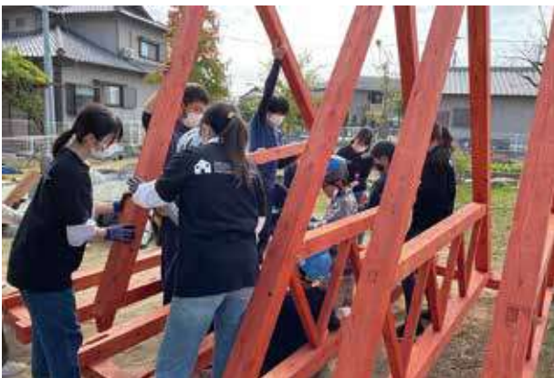
写真1 「いえづくりプロジェクト」組み立ての様子
