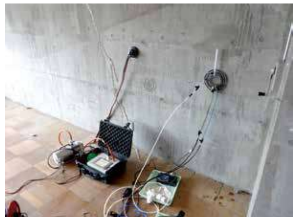
図3 表面吸水試験装置による実構造物調査
