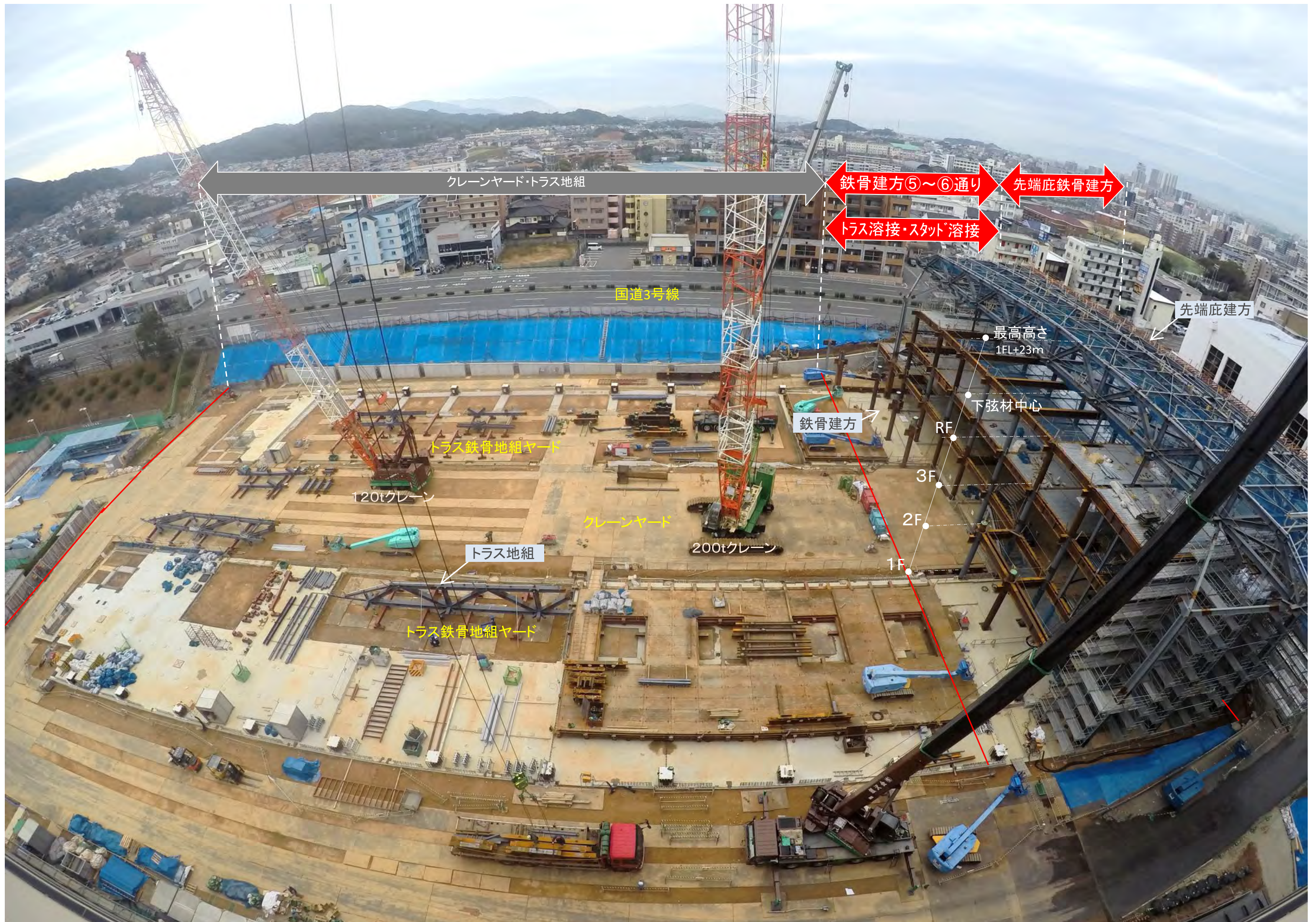
2019.2.15 全景(三号館屋上)
