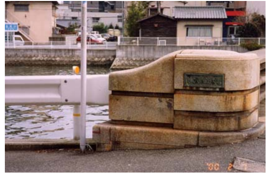
藤崎の飛石橋：北筑軌道と引込線との接続付近とみられる場所
