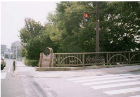
室身川筑肥橋
