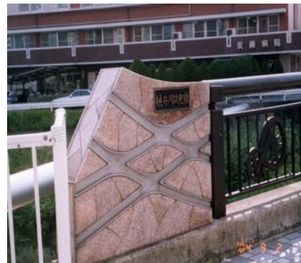
樋井川筑肥橋
