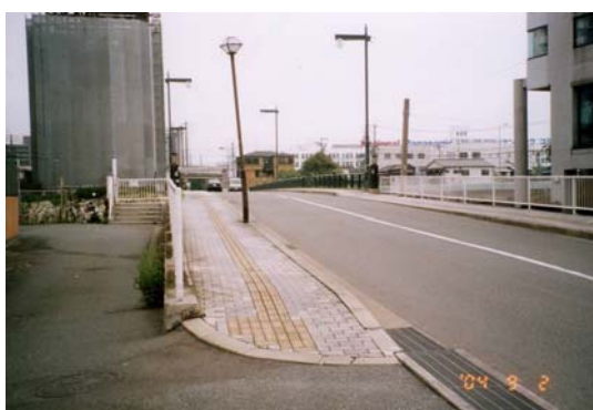
那珂川筑肥橋
