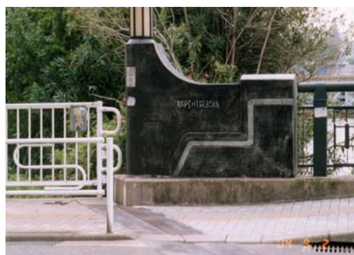
那珂川筑肥橋
