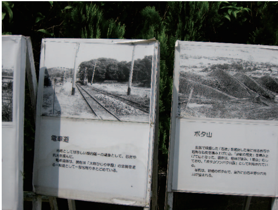
煉瓦館にあった写真1（電車道とボタ山）
