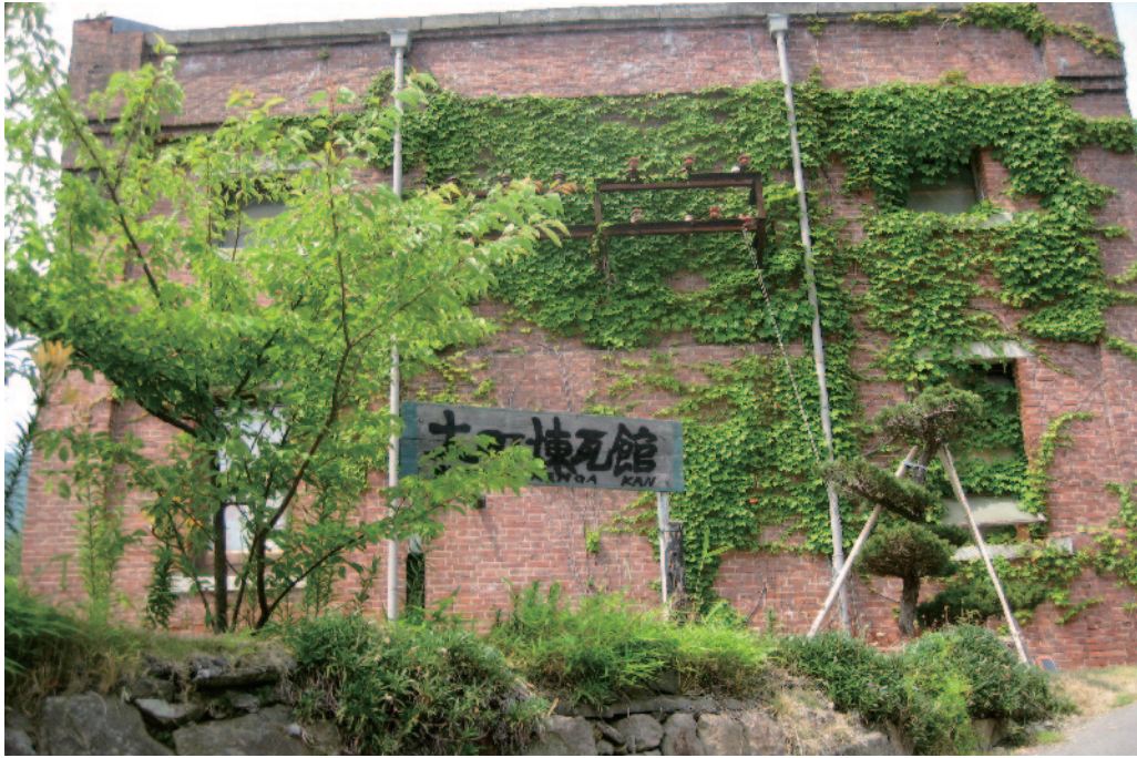
煉瓦館杵島炭鉱の変電所跡
