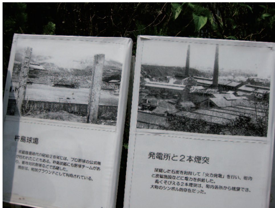
煉瓦館にあった写真2（杵島球場、発電所と2本の煙突）
